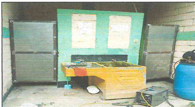
Foto 3: Reparación de puertas de metal (baños)
