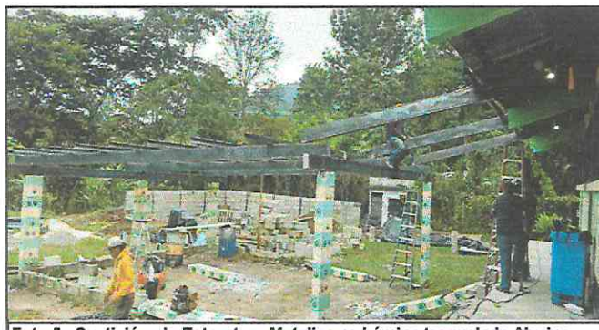
Foto 5: Sustitución de Estructura Metalica y Lámina troquelada Aluzinc calibre 26
