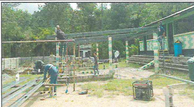
Foto 2: Sustitución de Estructura Metalica y Lámina troquelada Aluzinc calibre 26
