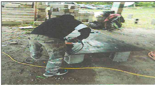
Foto 4: Ampliación y Sustitución de estructura Metálica y Reparación en general de puertas de Metal.
